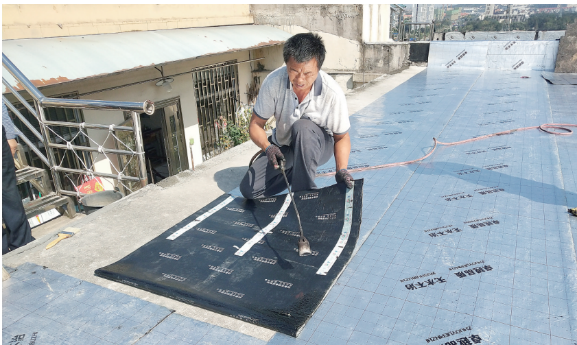
师傅在露台铺设防水材料的场景。
