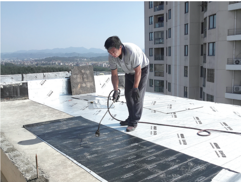
师傅在铺设防水材料
