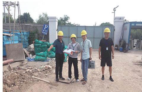
生产建设项目监督检查
