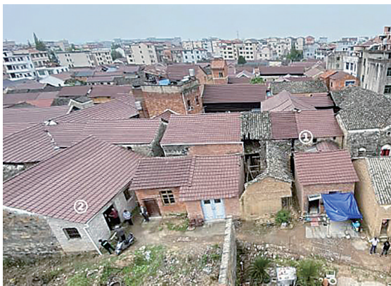
雅庄村黄鼎生牺牲地旧址,为养伤房间,为放寿材的厅
