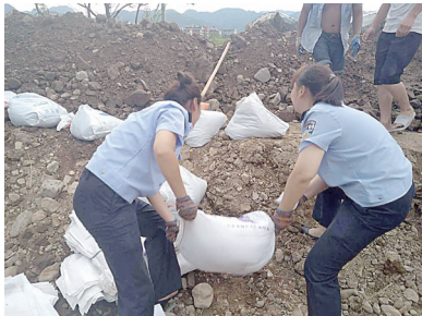
流管队员清理河道加固堤坝
