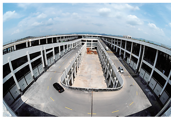
能诚集团高效厂房
