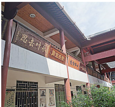
获赐的牌匾挂满二楼
