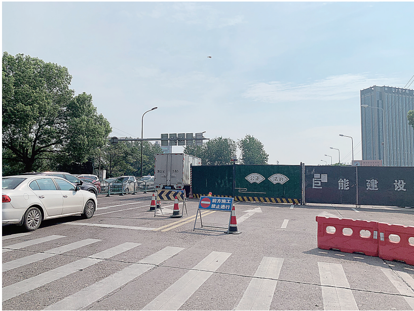
维修中的望春桥
