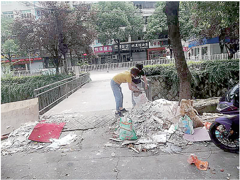
堆放在路边的建筑垃圾
