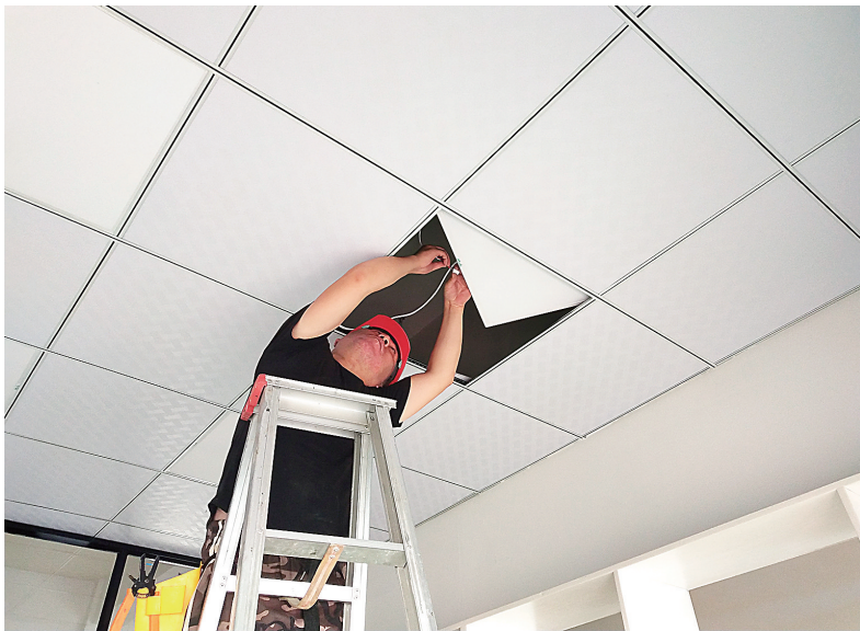
凌师傅在铺设电线
