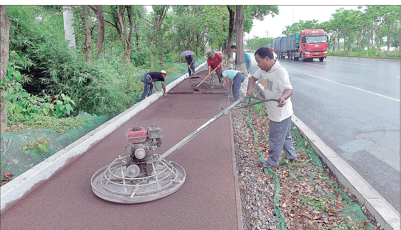
修建游步道 6月19日,记者在城西新区花城路看到,几名工人正在修建游步道。据介绍,这条游步道总长约1500米,建成后将为附近居民提供一个休闲健身的好去处。 记者 杨成栋 摄
