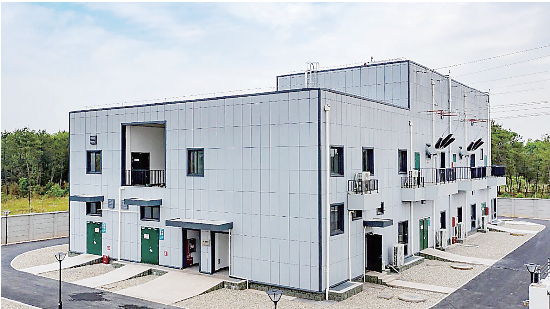
西田变电站外景
