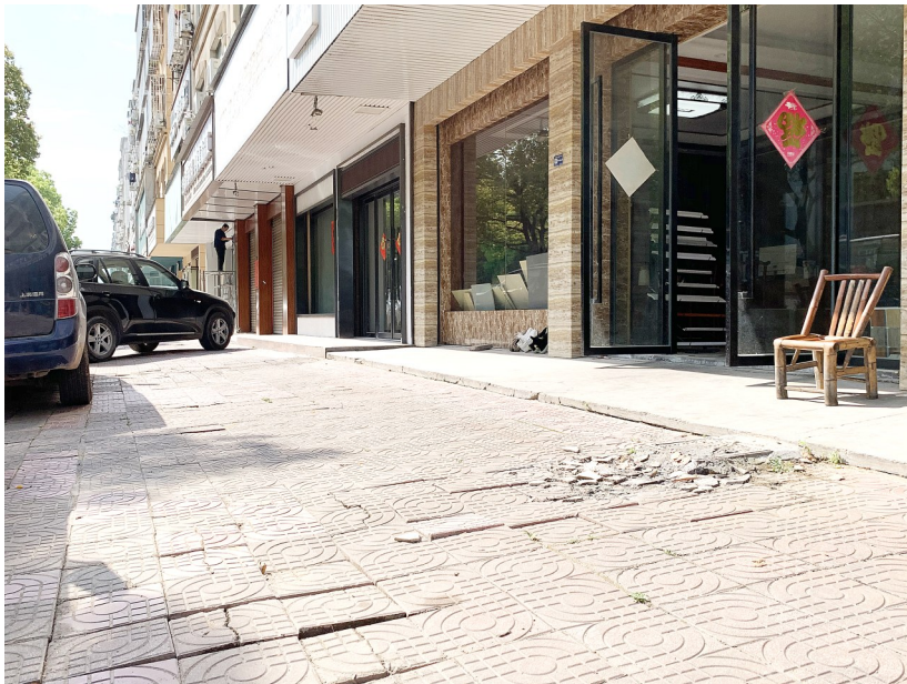
城北西路破损的人行道小平板
