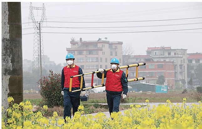
电力人员到田间地头检修电路
