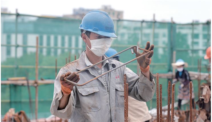
▲永康市车头、塔海自然村城中村改造项目现场
