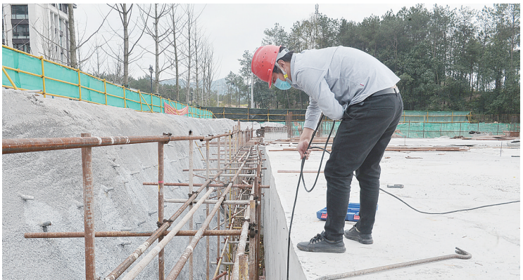
▲南溪湾生态湿地景观公园北入口区块工程现场
