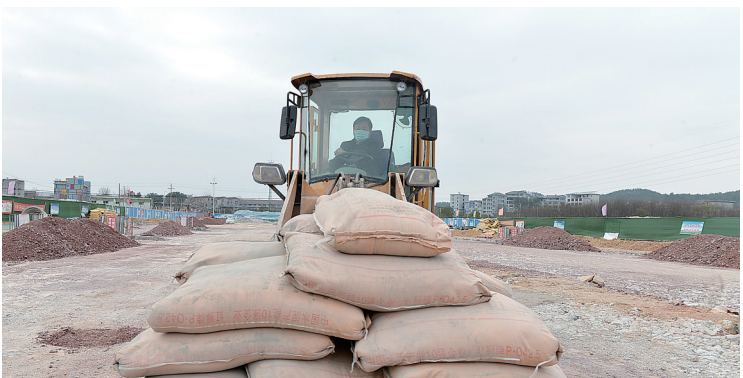
▲北三环(紫微北路—东永二线)项目现场
