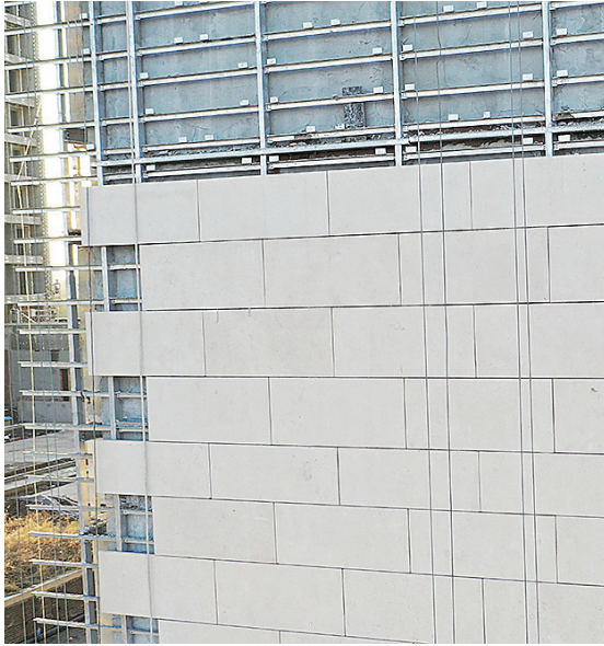
外立面施工中
