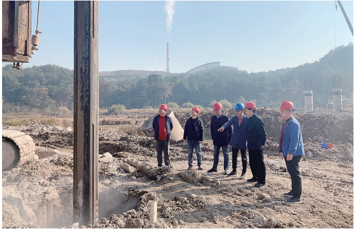
市纪委监委重点工程项目落实情况专项督察行动组,在330国道改建工程城西新区段督察。
