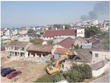
西溪镇幼儿园政策处理完成,拆除旧房。
