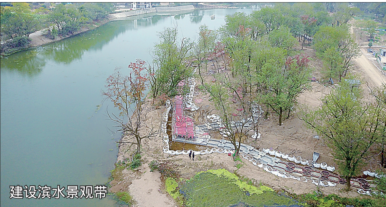
建设滨水景观带 18日,记者在南溪湾生态湿地景观公园看到,施工人员正在滨水景观带项目现场进行施工作业。据悉,滨水景观带总绿化面积2.9万平方米,其中滨水栈道面积969平方米。 记者 林群心 摄
