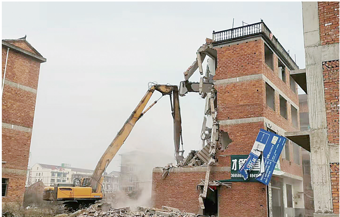
诚信路延伸工程拆除现场
