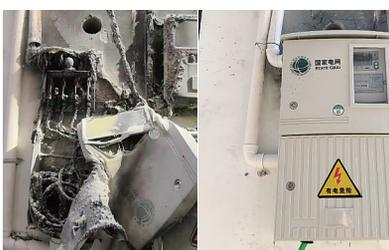
地上一堆灰烬,悬挂电表箱的白墙也被熏黑。为了确保抢修安全,我们先用干粉灭火器,对其进行了处理。卢涌伟说,事故原因是用户用电超负荷使用所引起的停电事故。幸好只是电表被烧,电路损坏,现场没有任何人员伤亡。
