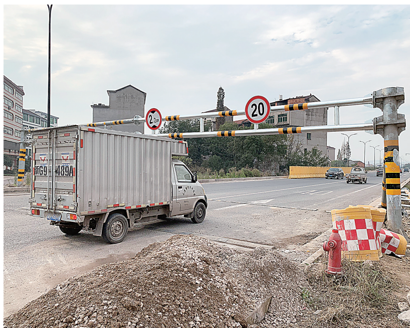
被撞变形的限高杆已修复
