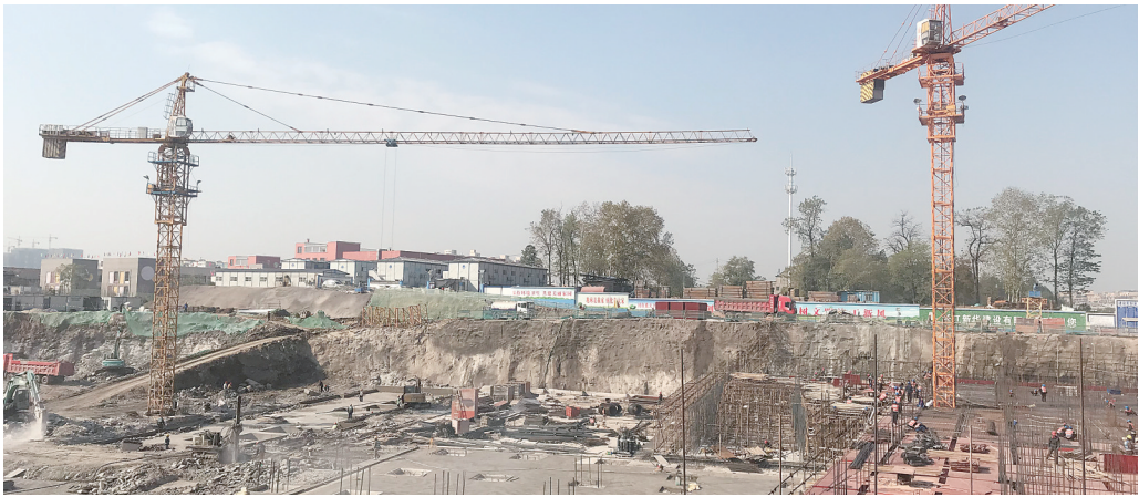
锦绣学府项目施工现场
