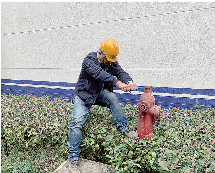
钱江水务工作人员在修理消防栓
