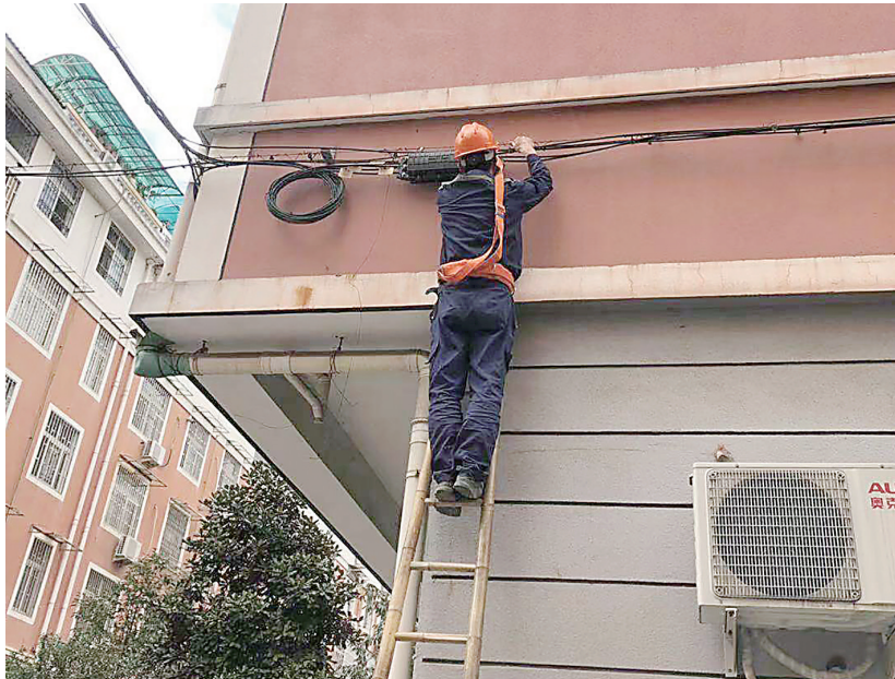
维修人员理顺并固定掉落的线缆
