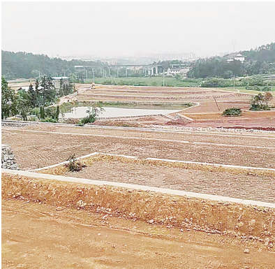
上宅口村项目施工现场
