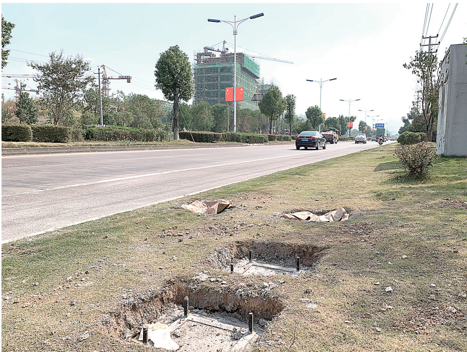
被拆除的候车棚处已放置地脚预埋件
