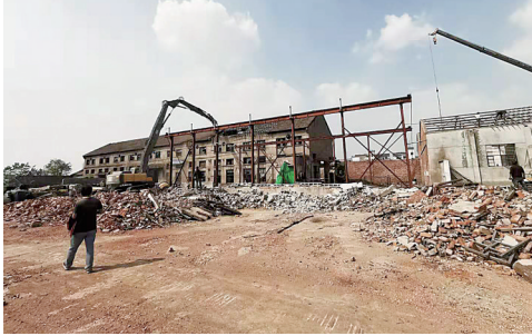
堰头小微企业园拆迁现场
