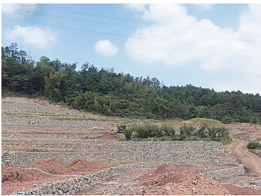
“旱改水”施工现场
