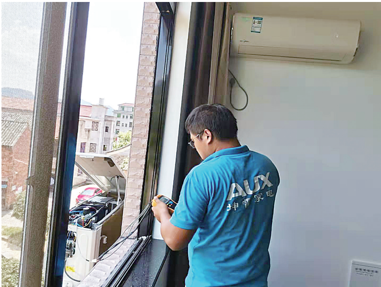
维修师傅用万能表检测空调外机
