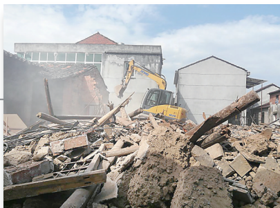
四路口中村危旧房拆除现场
