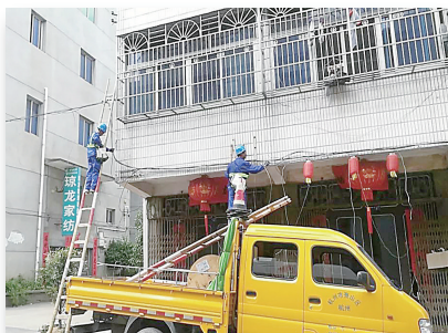
四路口上村线乱拉整治现场
