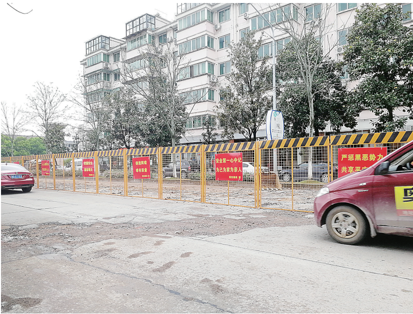
已填埋修补过的路面。
