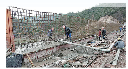
北部水库联网二期工程施工现场
