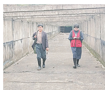
姐妹花记者行走在塘里渡槽
