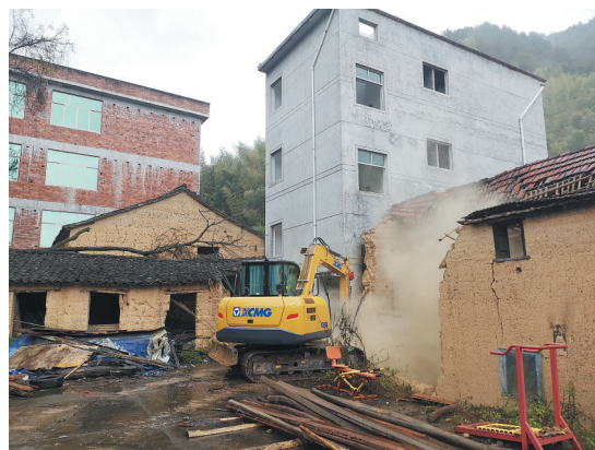
避让拆迁现场
