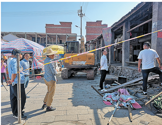
半面街拆除现场
