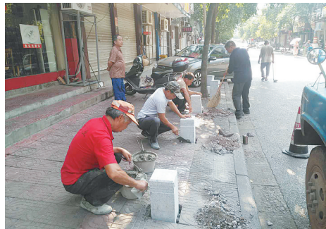
人行道安装隔离桩
