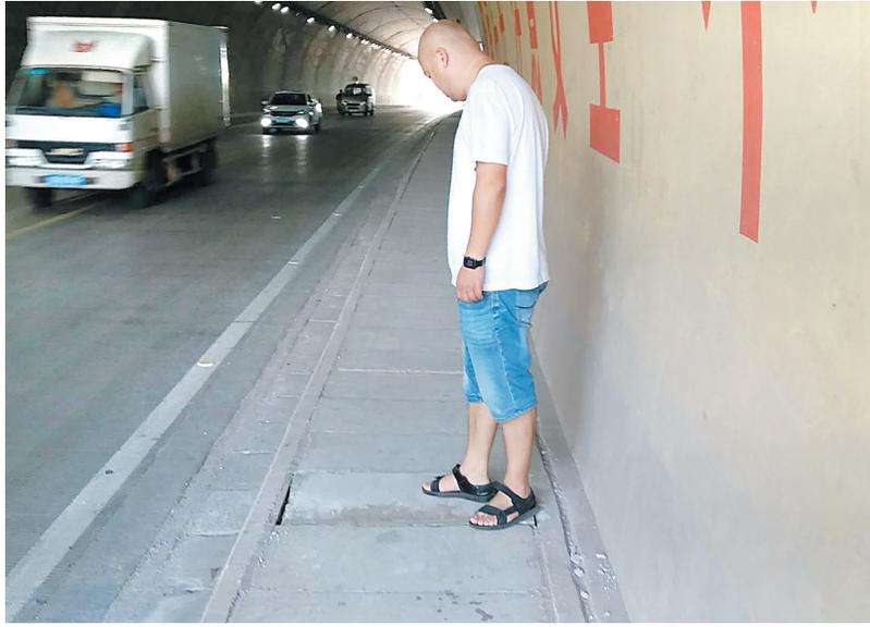
着铺着水泥板的人行道走了一段路 ,发现这些水泥板大多比较陈旧 ,表面都有或深或浅大小不一的裂痕。有几块水泥板比较新 ,显然是后面修补上去的。隧道内光线尚可 ,但车流量很大 ,且附近有许多大型施工车辆快速驶过 ,说话音量基本被过往车辆的杂音掩盖。
