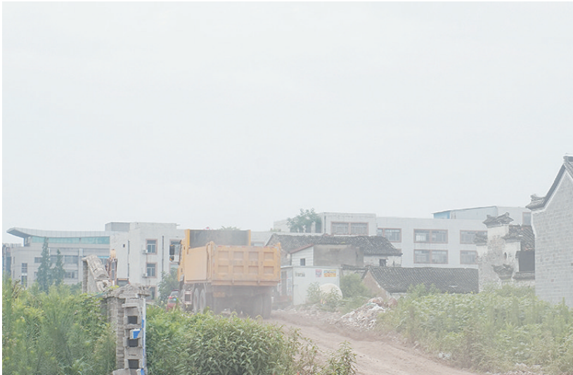
渣土车经过时尘土飞扬
