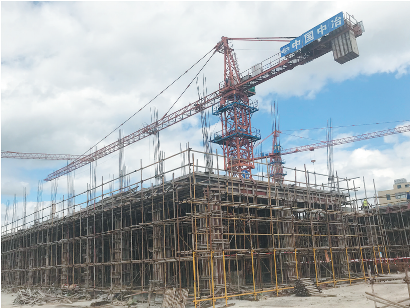
盛世联合商贸中心项目建设现场
