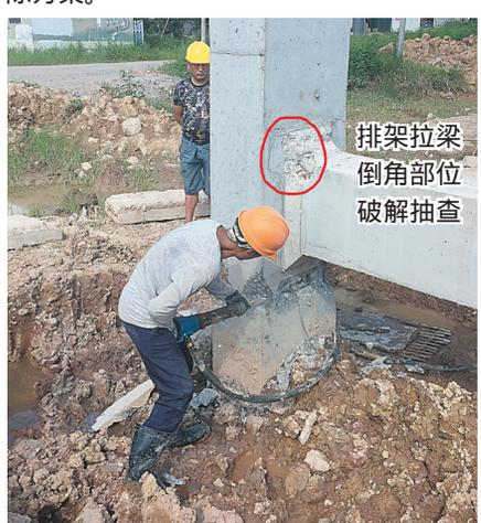
排架拉梁倒角部位破解抽查
