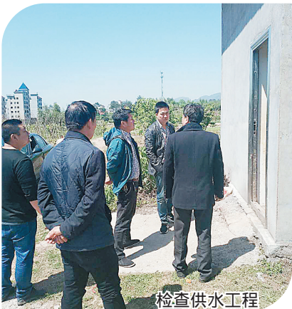
检查供水工程
