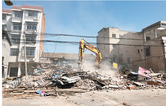
东库城中村改造现场
