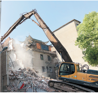
东库经济合作社拆迁现场
