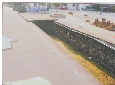
水渠变成臭水沟
