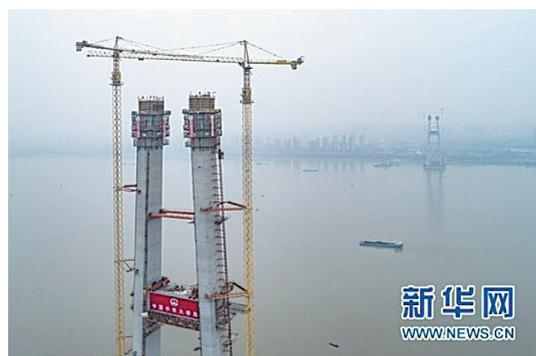
随着最后一立方米混凝土完成浇筑,武汉杨泗港长江大桥北岸两百多米高的主塔21日成功封顶,标志着这座世界最大跨度双层悬索桥建设完成关键性节点任务。
