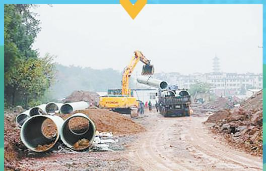
南苑西路建设工程正在埋设雨污水管网
