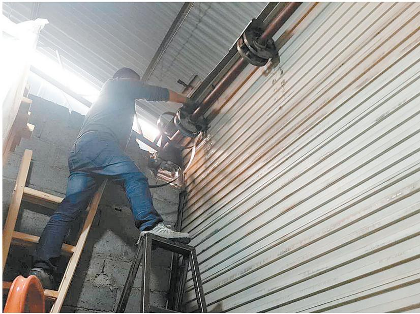
千万别这样推拉。张师傅连忙上前阻止。他说,手动卷帘门的各个零件中,最容易损坏的就是缠绕在滚轮上的弹簧,使用时间太久和暴力推拉卷帘门都会损害弹簧。笔者观察到,这扇手动卷帘门的底片中间已出现一道裂缝,裂缝处还向上凹陷了三厘米。
